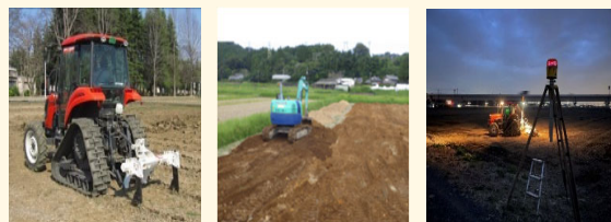
[例]排水対策（明渠、暗渠） 土層改良（客土） 傾斜均平
